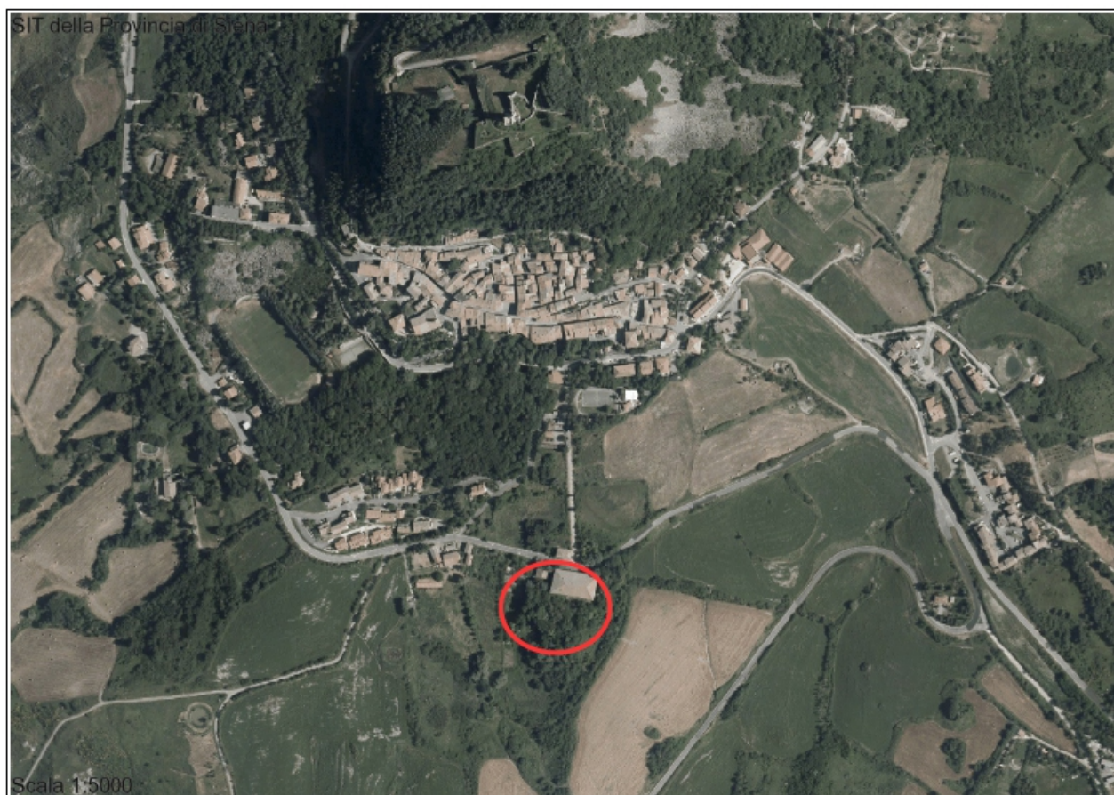
SIT della Provincia di Siena – Ortofoto 2013 con evidenziata la posizione dell'ex Posta medica nell'abitato di Radicofani.
